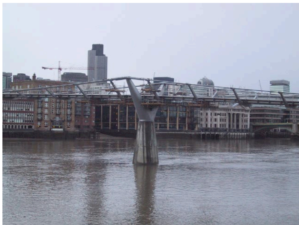
写真3・橋脚と主塔
